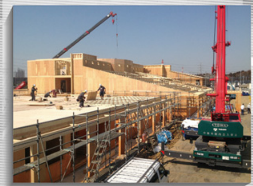
「特別養護老人ホーム みやぎ台南生苑」2014年度、当社で最初に関与した大規模木造物件です。千原産材の耐火建築です。
