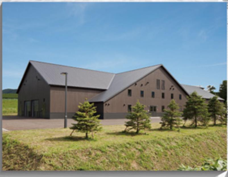
多雪地(140cm)に建つ400坪のワイン工場「倉庫ワイナリー」です。屋根トラスは高さ5.4mのコネクストラスを上下4分割して施工しております。
