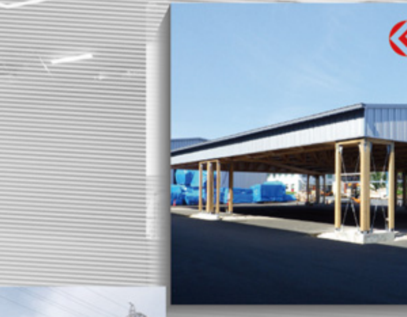
スマート倉庫:2018年「ウッドデザイン賞」、2019年「ウッドデザイン賞」受賞しました。テント倉庫に替わる施設型倉庫で、潔とした佇まいが特徴です。
