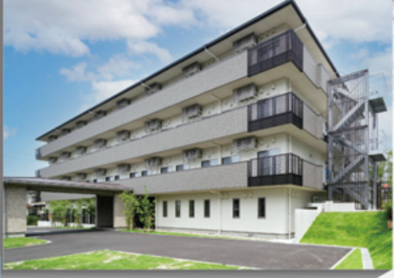
2022年に竣工した「京都インターナショナルユニバーシティ 辺野田キャンパス」です。令和3年度「JAS」構造材認証事業に採択され、京都市産材を建築物本体に採用しています。また、屋根はダブルスルーバルド(木造)コネクストラスを利用頂き、現しの表観で開放的な空間を演出しています。
