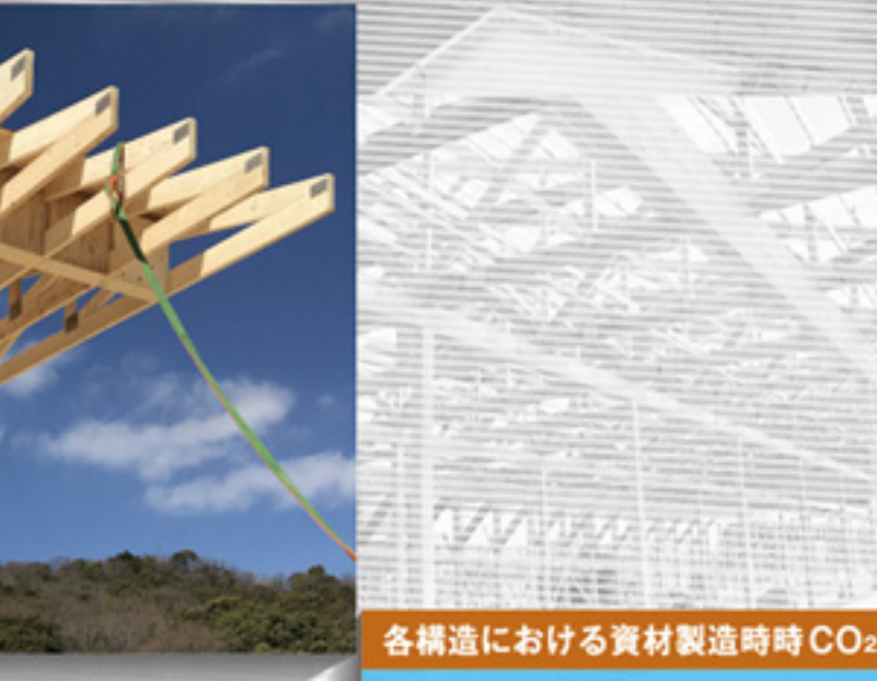
20mを超えるような大スパンの「コネクストラス」は、2分割して挿入し、現場で接合しております。屋根形状によっては上下分割になる場合もあります。私たちは安全を最優先に、トラスを「ユニット化」する施工方法を併せて開発して参りました。これは設計・施工部門が協力を取り組んでいる当社の特徴でもあります。
